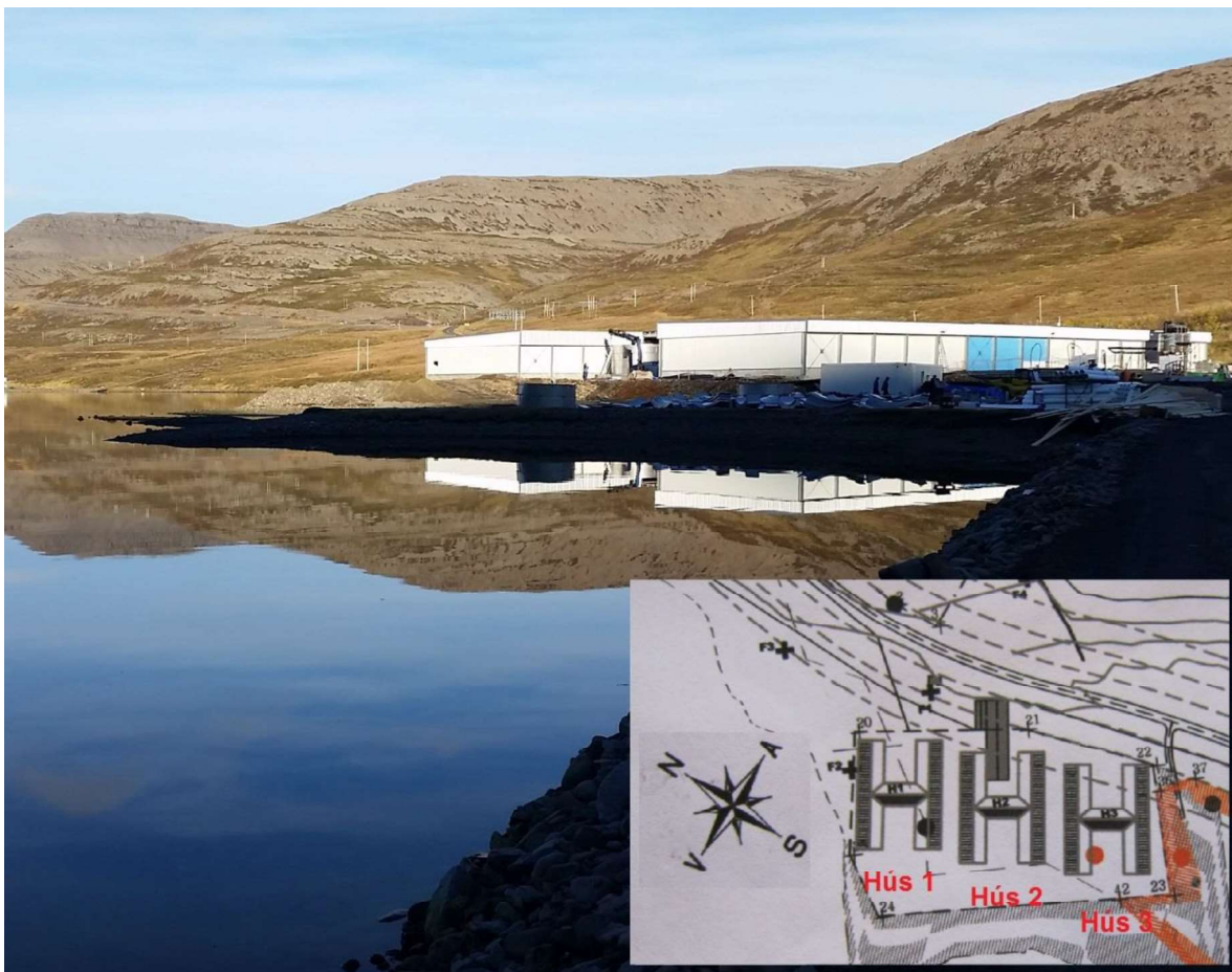
Mynd 4-1 Seiðaeldisstöð fyrirtækisins Arctic Smolt ehf. í byggingu í Tálknafirði. Seiðastöðin samanstendur af þremur húsum sem hvert um sig er 3.000 m 2 og kerjarými innanhús verður samtals 8.400 m 3 . Lokið er að mestu byggingu á einu kerjahúsi (hús 1) og annað hús er langt komið (hús 3). Myndin sýnir fyrsta húsið sem þegar er komið í notkun og Hús 3 er að hluta komið í notkun. Innföld mynd sýnir staðsetningu eldisstöðvarinnar, neðan þjóðvegur í botni Tálknafjarðar.
